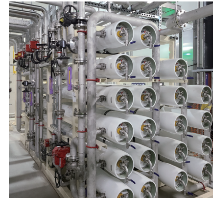
순수제조장치(DI Water System) / 2차전지 배터리
